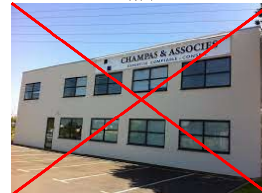
Enseigne bandeau en partie haute de la façade Proscrit
